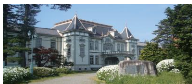
旧米沢高等工業学校本館 (現・工学部資料館) ※画像: 山形大学様ご提供
